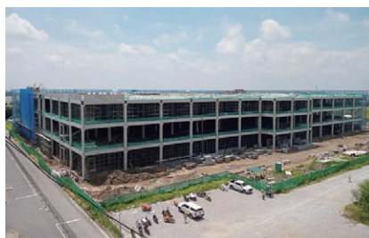
2022年8月 PC建方工事完了
