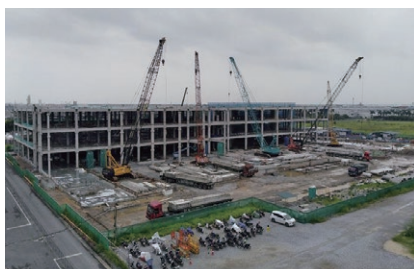
2022年6月 PC建方工事(5スパン目)
